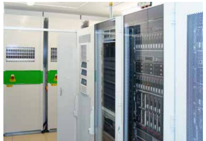
Mobiles Datacenter mit Slim Line Klimatisierung
