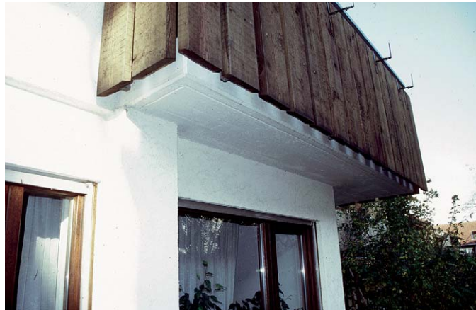
Abb. 10.1: Balkon mit von innen nach außen durchlaufender Balkonplatte aus Beton
