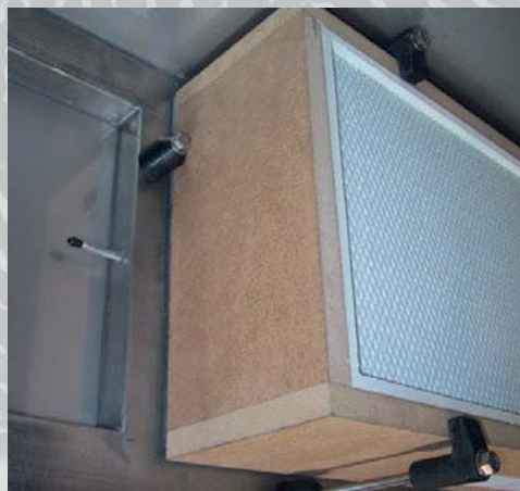
Filtereinbau mit Dichtsitzprüfung bei Typ LCS.
