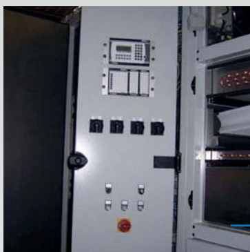
Die Bedien- und Anzeigenelemente sind bedienfreundlich in die Gerätetür eingebaut.
