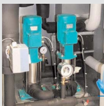
Die Kälteanlage ist im Maschinenraum vom Luftstrom getrennt untergebracht. Optional kann die Kälteanlage als Wärmepumpe für den Heizbetrieb genutzt werden.
