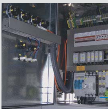
Die Schalt- und Regelanlage ist vom Luftstrom getrennt in die Gerätefront eingelassen.
