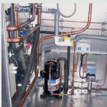
Die Kälteanlage ist im Maschinenraum vom Luftstrom getrennt untergebracht. Optional kann die Kälteanlage als Wärmepumpe für den Heizbetrieb genutzt werden.
