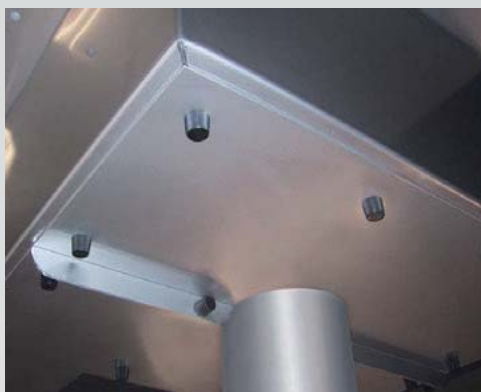
Lampenschacht mit geteilter Wartungsplatte.
