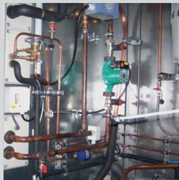
Leicht zugängliche Wasserinstallation für KVS- und PWW-Regelgruppen. Hygienische, luftdichte Rohrdurchführungen durch die Gerätewand.
