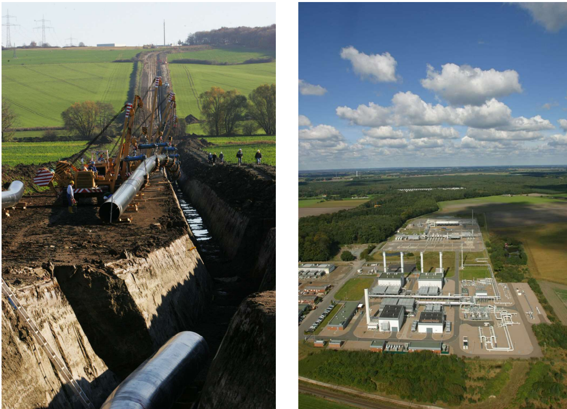
Abbildung 1.3 Links: Bau einer Erdgaspipeline in Ostdeutschland, rechts: Erdgasspeicher Rehden, 60 Kilometer südlich von Bremen für 4,2 Milliarden Kubikmeter Erdgas (Fotos: WINGAS GmbH)
