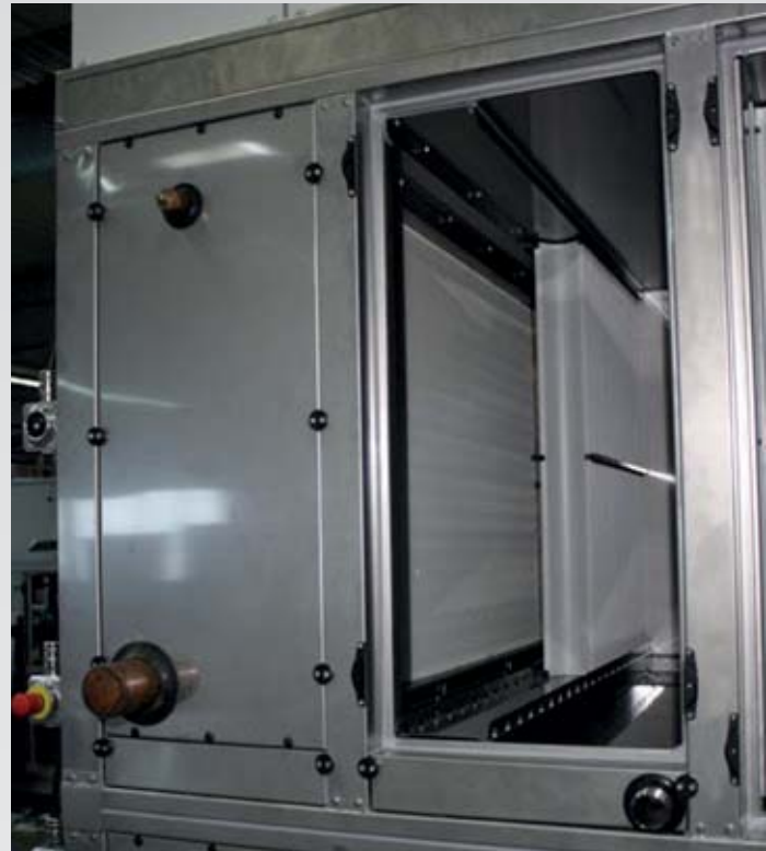
Bild 15: Tropfenabscheider in PPTV, alternativ AlMg3 oder Edelstahl
