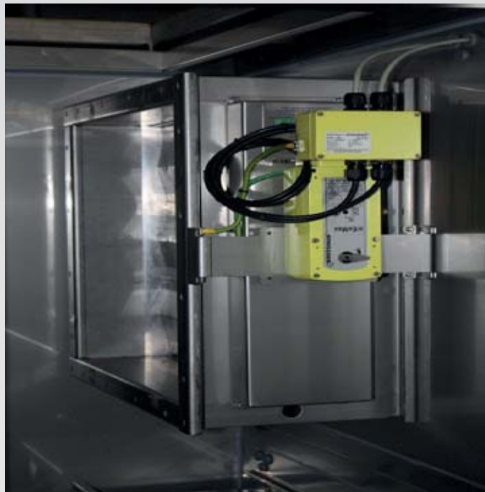
Bild 9: ATEX-Jalousieklappe mit elektrischem Antrieb
