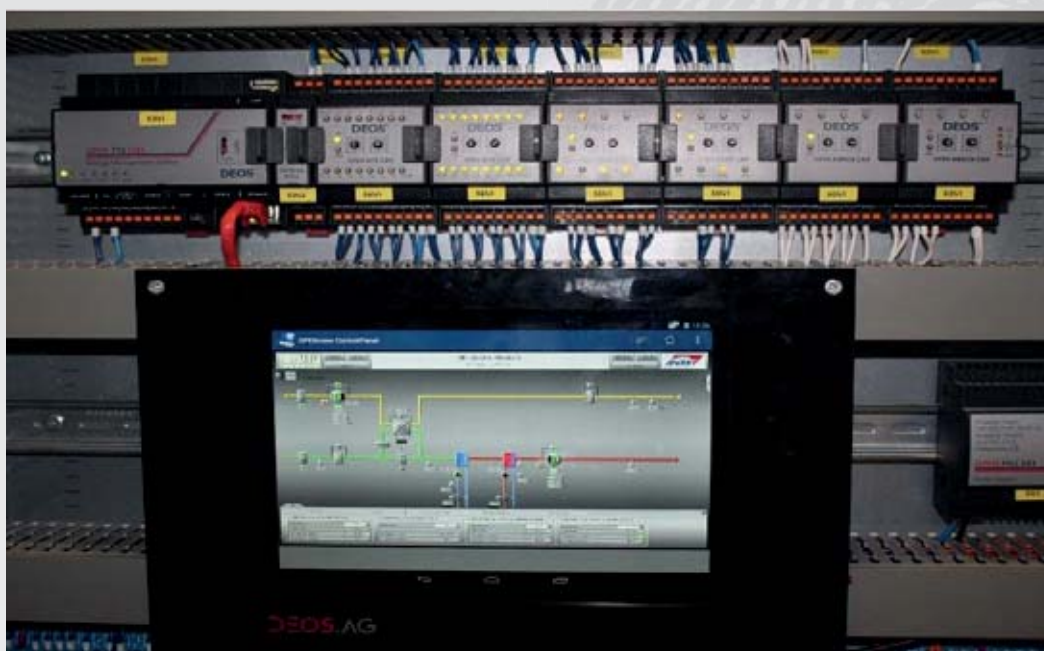
Bild 39: Regelung über DEOS mit Multitouch-Tablet und Visualisierung der Anlage
