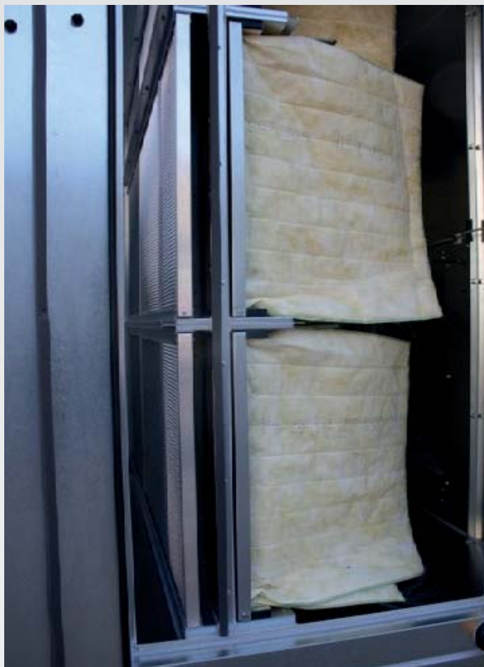
Bild 10: G2 Metallfilter und F7 Taschenfilter
