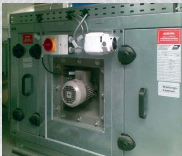
Bild 20: Ventilator mit vom Luftstrom getrenntem Motor
