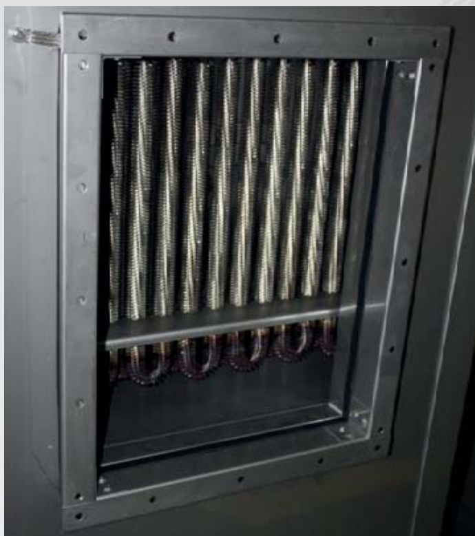
Bild 24: Kanalanschlussstutzen gemäß ISO 15138
