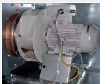
Erdung Ventilator
