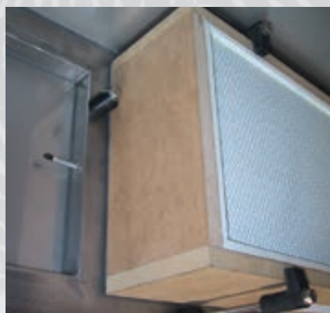
Filtereinbau mit Dichtsitzprüfung bei Typ LCS.
