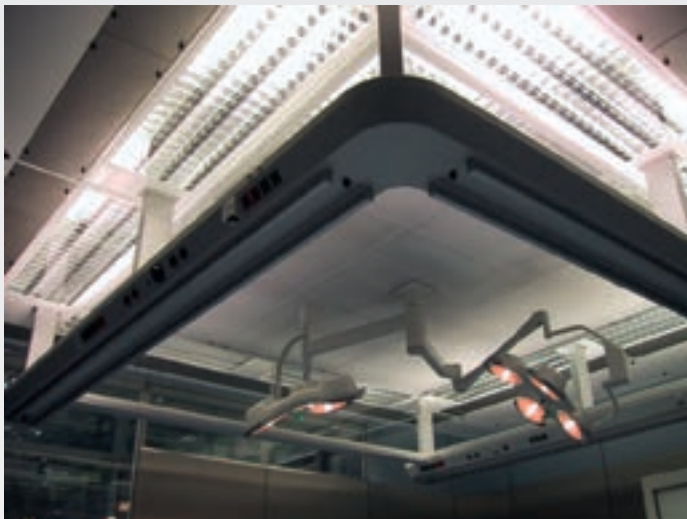
ROX Zuluftdecke für OP-Räume Typ LCS.
