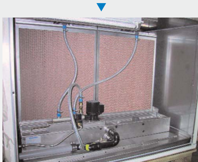
Kontaktbefeuchter zur adiabaten Abluftbefeuchtung
