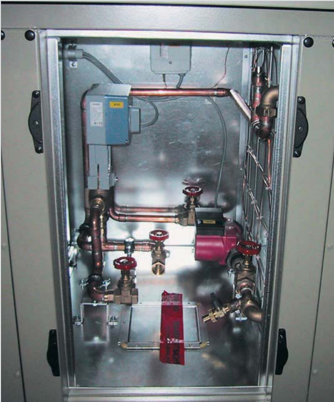
Regelgruppe für PWW vom Luftstrom getrennt im Gerät integriert.
