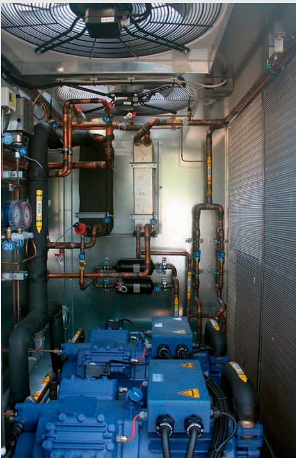
Integrierte Kälteanlage mit natürlichem Kältemittel R290.
