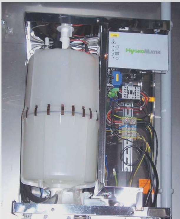
Elektrischer Dampferzeuger funktionsfertig im Maschinenteil des Gerätes integriert.
