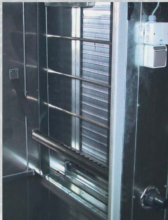
Dampfdüse im Gerät eingebaut, Befeuchtungskammer innen aus Edelstahl mit Wanne und Ablauf.
