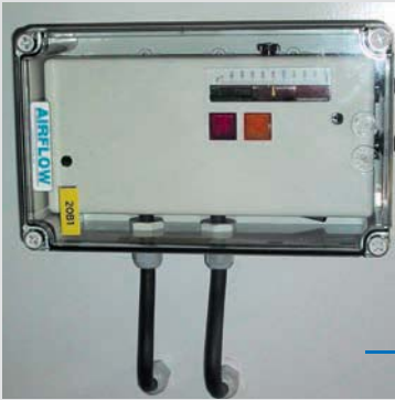
Filterüberwachung mit elektrischem Schaltkontakt Schutzart IP65.
