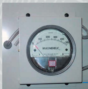
Zeigermanometer zur Filterüberwachung.
