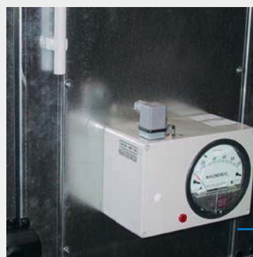
Zeigermanometer mit elektrischem Schaltkontakt zur Filterüberwachung.
