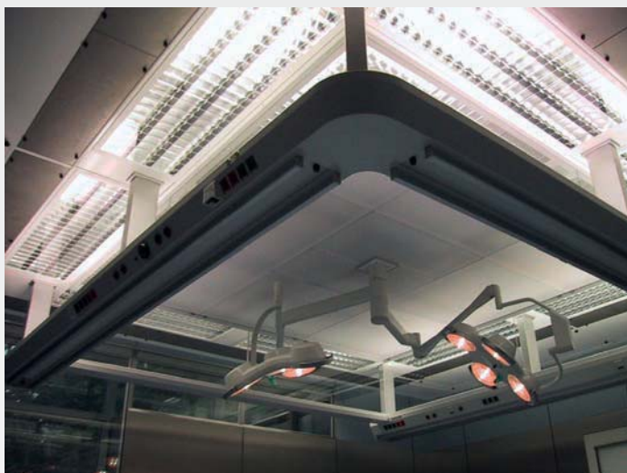
ROX Zuluftdecke für OP-Räume Typ LCS.
