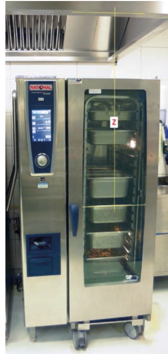
Abbildung I-5-4: Aufstiegshöhe z bei einem Heißluftdämpfer
