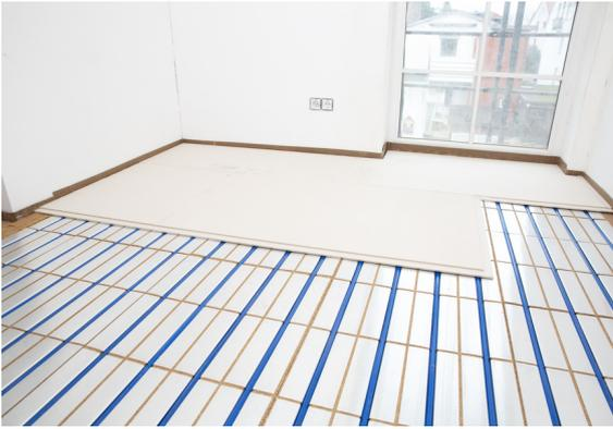
Bilder: Trockenestrich auf Holzfaserdämmung
