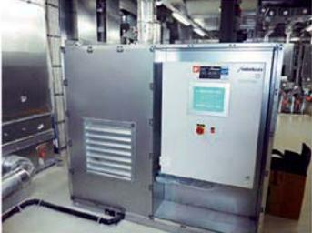
**Logistikzentrum Civitas Nova Wiener Neustadt (A), Wärmerückgewinnung mittels Hochleistungs-Kreislaufverbund-System**
