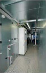
**Krankenzimmer Prellwiesing (D), RLT-Geräte als begehbare Dachzentrale ausgeführt**
