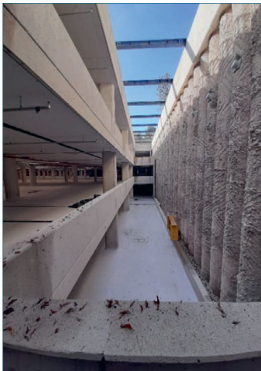
Bild 23: Beispiel der Zuluft einbringung über einen Lichtsacht in einer Großgarage Quelle: TROX X-FANS GmbH
