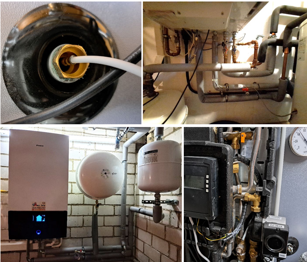
Bild 74: Beispiele für Auffälligkeiten bei den untersuchten Anlagen: Speicherfühler passt nicht (oben links), Isolierung lückenhaft und Installation schwer nachzuvollziehen (oben rechts), ungedämmter Rücklaufspeicher rechts (unten links) und fehlende Ableitung am Überdruckventil (unten rechts)
