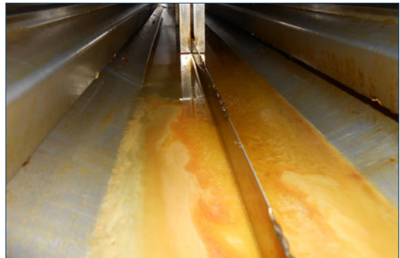
Auflageschiene Dunstabzugshaube belastet
