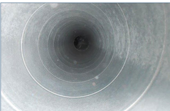
Innenansicht Kanal nach der Reinigung
