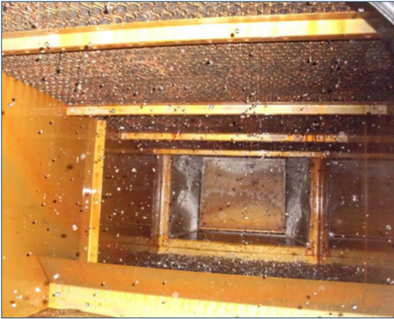
Innenansicht einer Kühlturmtasse
