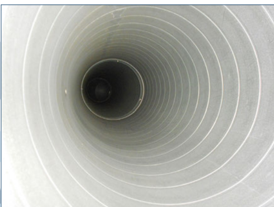
Innenansicht Kanal nach der Reinigung
