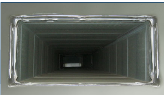
Innenansicht Kanal nach der Reinigung
