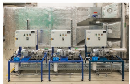
WinCool-Befeuchtung: Vollautomatische Mikroprozessorensteuerung
