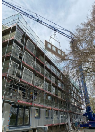
Einbau der vorgefertigten Holzrahmenbauwände
