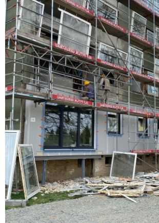
Ausbau der alten Fenster
